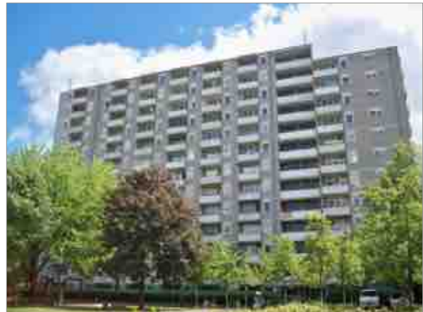
unsaniertes Wohngebäude aus den 1960er-Jahren
