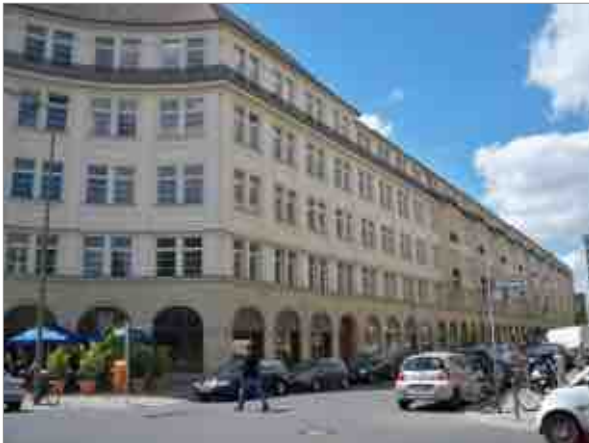
teilsaniertes Gründerzeitgebäude ohne energetische Maßnahmen
