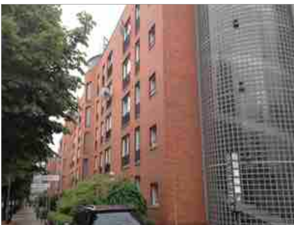
unsaniertes Wohnhaus aus den 1980er-Jahren
