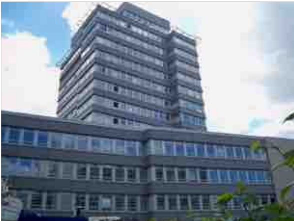
saniertes Bürogebäude aus den 1970er-Jahren
