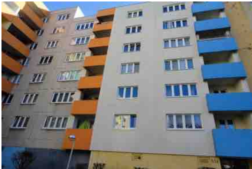
Teilsaniertes großes Mehrfamilienhaus in Maulbeerallee
