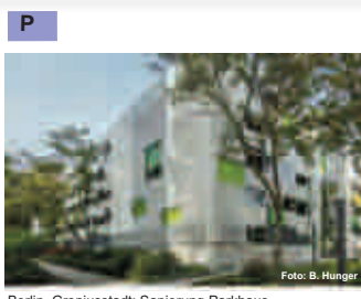
Berlin, Gropiusstadt: Sanierung Parkhaus
