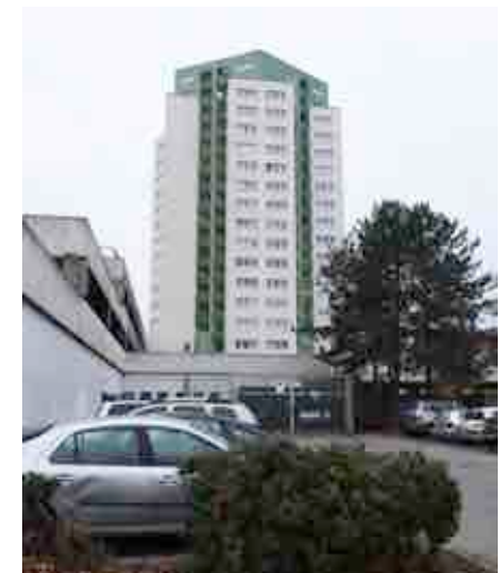
Die Parkhaus-Rückseiten sind abends unsichere Orte.
