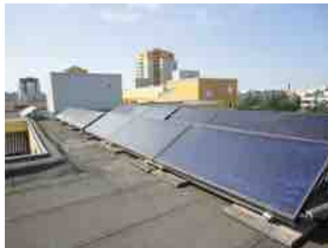
Solarthermieanlage
