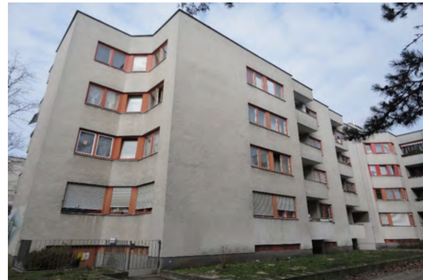
Abbildung 3.8: Unsanieretes großes Mehrfamilienhaus in der Heerstraße
