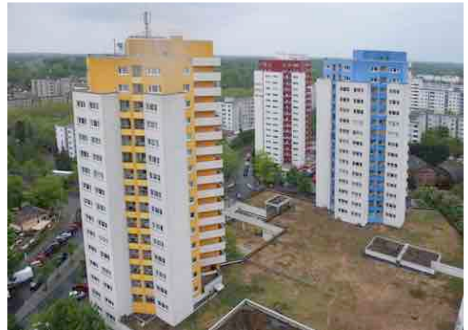
Ortsteilzentrum: Dachfläche auf dem Staaken-Center – Potenzielle Fläche für ein ‚Begrüntes Dach‘
