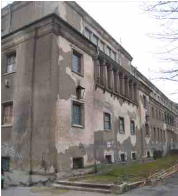
Abb. 1.4: Problemstandort Baudenkmal Hubertusbad
