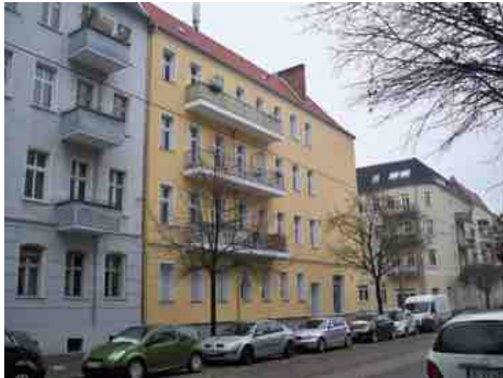
Saniertes Gründerzeitgebäude mit umfangreichen energetischen Maßnahmen
