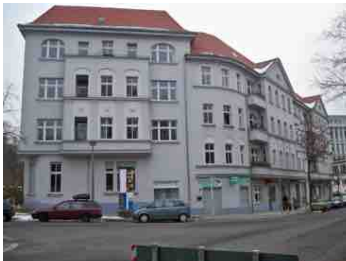
Saniertes Gründerzeitgebäude ohne energetische Maßnahmen
